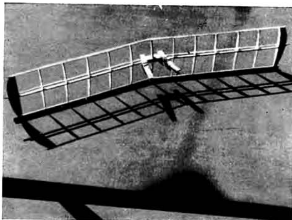
3 - Structure d'aile au séchage (CLAPAL-A 1)
